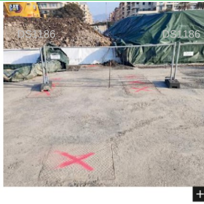
In basso, il luogo a Genova dove arriva il cavo BlueMed che collega Genova, Palermo e la Grecia
